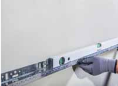
Figura 1 Boshllëqet, thellimet dhe zgjatimet ndërmjet murit dhe profilin të bazamentit Teknosistem (Socle) korrighohen me anë të kunjave me Trashësia të ndryshme dhe sipërfaqja matet me një matës libellë.
