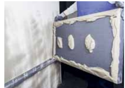
Figura 3 Kur aplikoni suva ngjitëse në pjesën e pasme të pllakës izoluese, duhet pasur kujdes që të mos dalë nga skajet.
