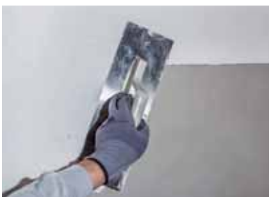
Figura 1 Suva dekorative minerale Teknosistem me teksturë aplikohet në sipërfaqe me mistri.
