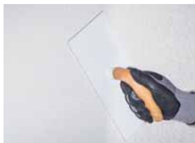
Figura 2 Aplikohet me një mistri plastike mbi sipërfaqe për të formuar një teksturë përpara tharjes.
