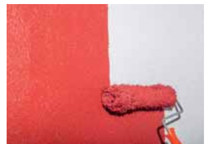
Figura 3 Së fundi, aplikohet baza dhe lyhen muret e jashtme.
