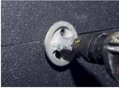
Figura 1 Kërkohe prerje me vegla për të vendosur plotësisht kokën e tapës së murit dhe për të parandaluar trashjen.
