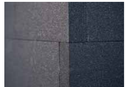
Figura 3 Pllakat termoizoluese vendosen pa boshllëqe dhe në stil zig-zag duke filluar nga fundi i murit dhe duke u ngjitur lart. Panelet duhet të vendosen në një stil zig-zag në qoshe.
