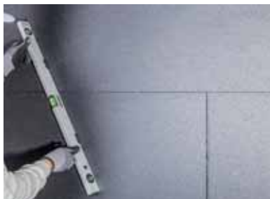
Figura 2 Nivelet e pllakave duhet të kontrollohen me një nivelues (libela).
