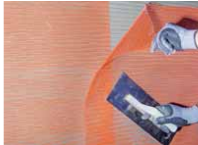
Figura 2 Rrjeta e fibrës së qelqit duhet të aplikohet në shtresën e parë të suvasë sipërfaqësore kur ajo është ende e lagur duke e shtypur shumë fort dhe shtrirë gjerësisht, pa e palosur dhe vendosur në një distancë të barabartë nga pllaka izoluese në të gjithë sipërfaqen. Lidhësit, rrjetat e tekstilit me fije qelqi duhet të mbivendosen gjithmonë me 10 cm.
