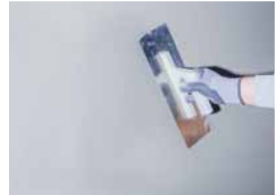
Figura 3 Aplikimi i shtresës së dytë të suvasë së gipsit përfundon pasi pritet një dehidrim i lehtë i shtresës së parë në varësi të kushteve të motit.
