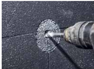
Figura 2 Venddodhja e tapës së murit është shpuar. Madhësia e vrimës duhet të jetë 1 cm më e madhe se madhësia e tapës së murit.
