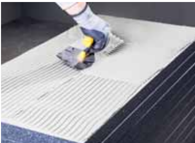
Figura 1 Nëse sipërfaqja është e sheshtë; suvaja ngjitëse aplikohet në të gjithë pllaka termoizoluese me mistri ose mistri të prerë siç duhet, duke përdorur metodën e ngjitjes në të gjithë sipërfaqen.
