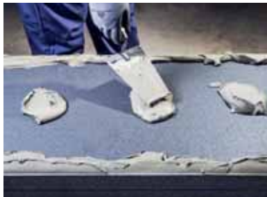
Figura 2 Nëse ka dallime në nivele ose pabarazi të sipërfaqes, suvaja ngjitëse aplikohet si shirita përgjatë të gjitha skajeve të pjesës së pasme dhe si pika në pjesët e mesme të pllakës termoizoluese me mistri, duke përdorur metodën të aplikimit të shiritave dhe pikave.
