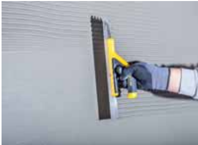
Figura 1 mbushja e pllakave termoizoluese Teknosistem dhe vendosja e tapave në mur, aplikohen dy shtresa suvaje sipërfaqësore. Suva gipsi e përgatitur Teknosistem aplikohet në mënyrë homogjene në sipërfaqe me mistri çeliku.
