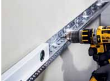
Figura 2 Pas procesit të nivelimit, profilin e bazamentit Teknosistem (Socle) montohen duke përdorur tapat në mur.
