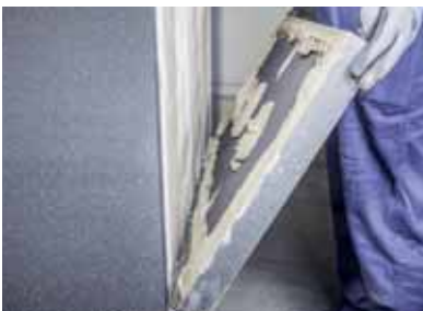
Figura 1 Pllaka termoizoluese me Llaç Adeziv të aplikuar në anën e pasme duhet të vendoset në profilin e fundorës (Socle) pa asnjë boshllëk.
